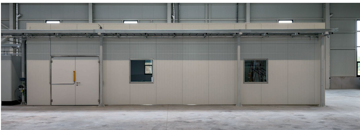
Maschineneinhausung mit Zugangstür und Sichtfenster
