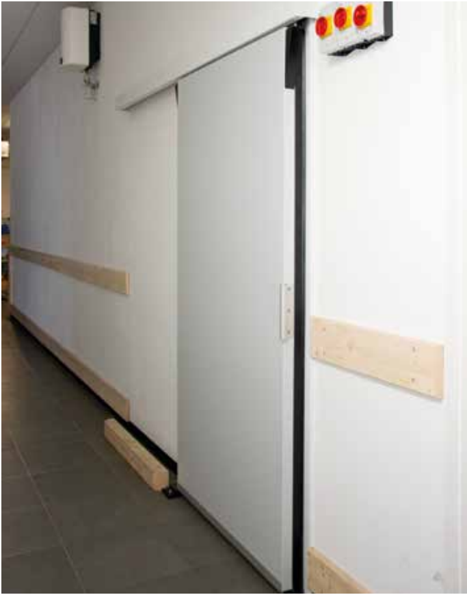
Fertig eingebaute Schiebetür (BSZE ROMA)
