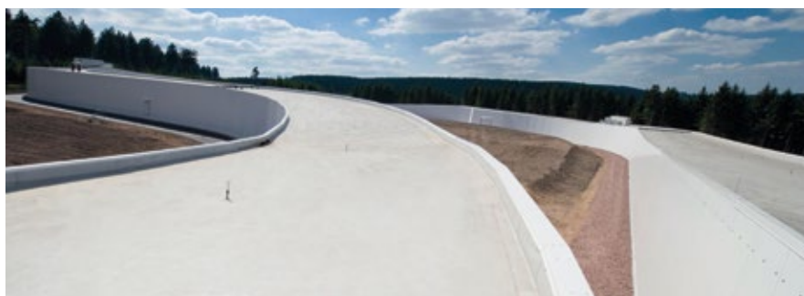
Differenzierte Gebäudeformen mit ROMA Schnellbau-Dämmpaneel (Skihalle Oberhof)
