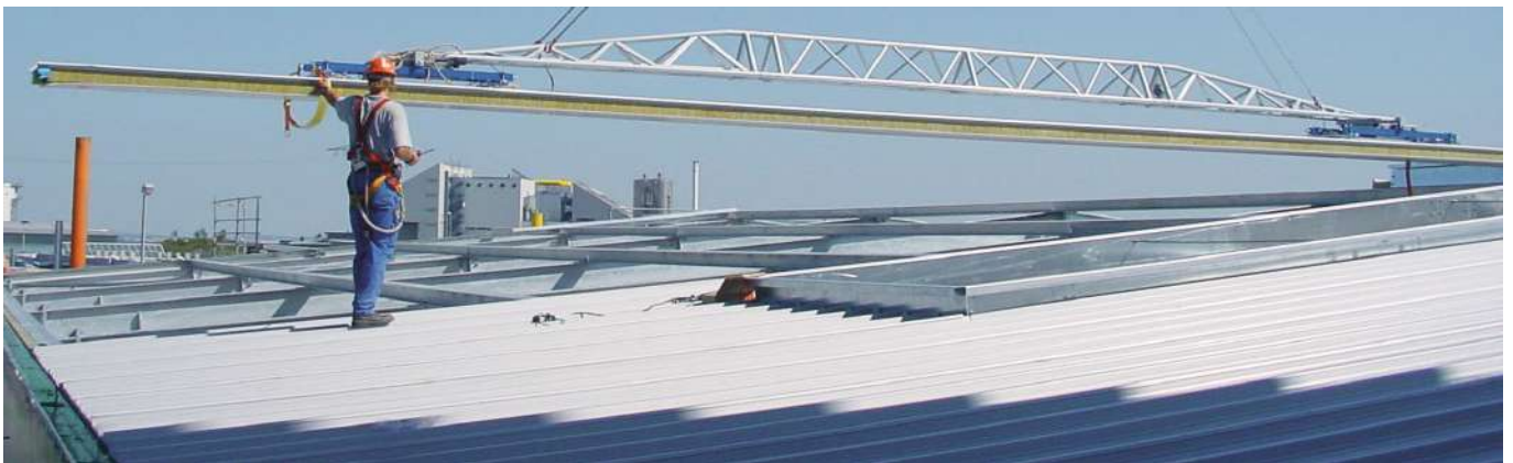
Beispiel einer Dachmontage mit Traverse
