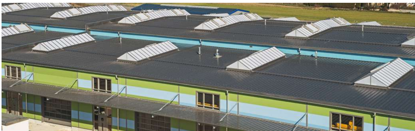
ROMA Produktionshalle mit langen Dachpaneelen
