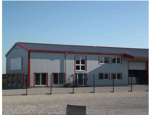
Produktionshalle mit Büro
